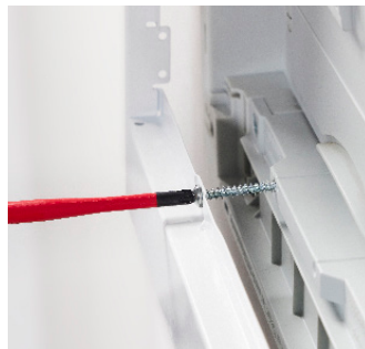
02 Putzausgleich bis 25 mm über Befestigungsschrauben des Blendrahmens
