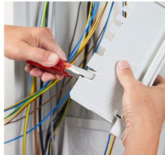
10 Einfaches Ausbrechen der Vorprägungen im Schieber zur Einführung von Leitungen
